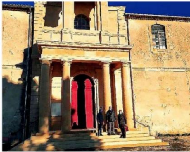
La deuxième phase des travaux comprend la réfection des façades du bâtiment.
